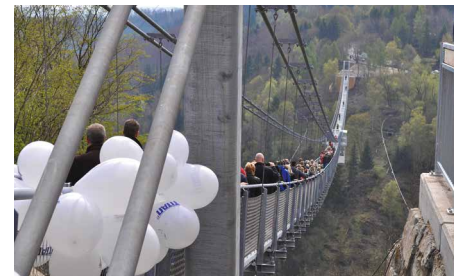
Rund 17.000 Besucher feierten die Eröffnung der Fußgänger-Hängebrücke „Titan-RT“.
