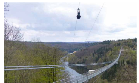
Über die Köpfe der Brückenbesucher hinweg fliegen die Teilnehmer der Mega-Fox-Anlage, welche wir bereits vor fünf Jahren an der Rappbodetalsperre installiert haben.
