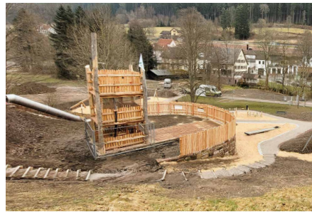
Blick auf den Spiel- und Erlebnisbereich mit Spielturn, Rutsche und Schaukel noch während des Baus.
