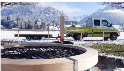
Montagearbeiten mit Blick auf die verschneite Oberstdorfer Bergwelt – hier entsteht eines der neuen „ming Plätze“.
